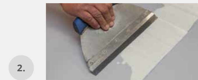
2. Aplikace lepidla / Applying glue / Anwendung des Klebers / Нанесение клея / Application de colle
